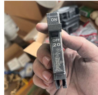
30 BREAKER 1F 20A, ENCHUFABLE
